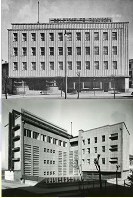
Resim3. İller Bankası Binası, Ankara ( http://www.mimdap.org/?p=198419 )
